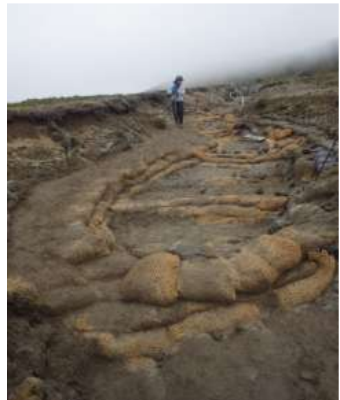
今回、土のうを積んで整備したところ
